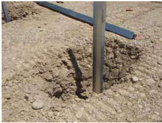
Figure 15 : Types de fondation - pieux battus (Source : Guide MEDDTL 2011 – NCA, 2015)
