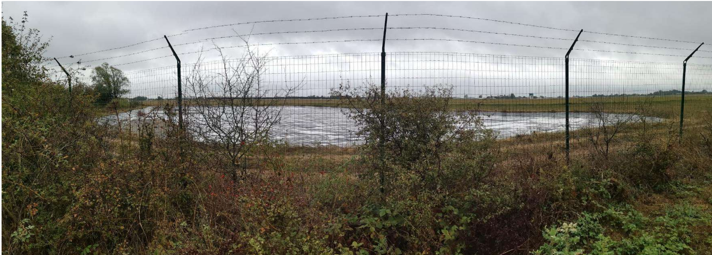
Photo 19 : Vue du bassin d'orage présent à l'extérieur de la zone au nord-est
