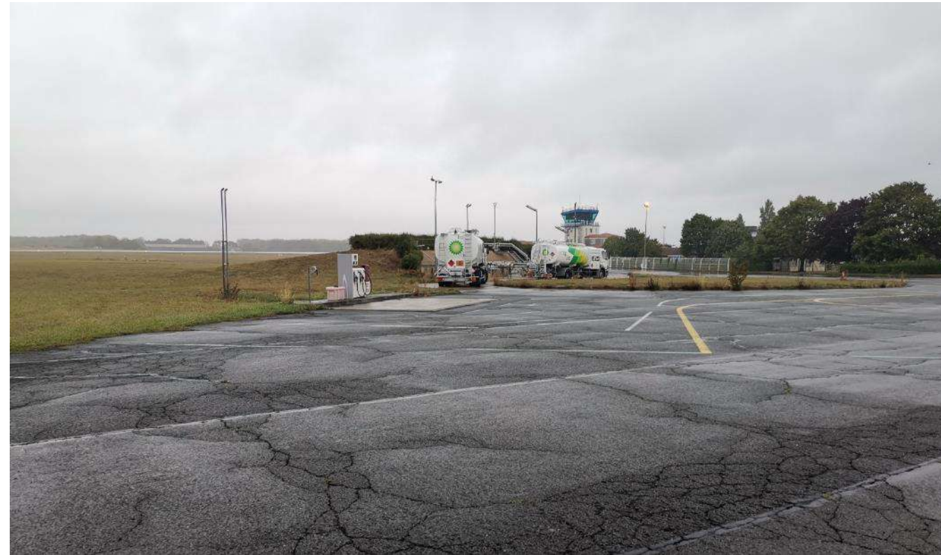
Photo 39 : Vue à droite de l'entrée sur site depuis la zone enrobée de circulation de l'aéroport
