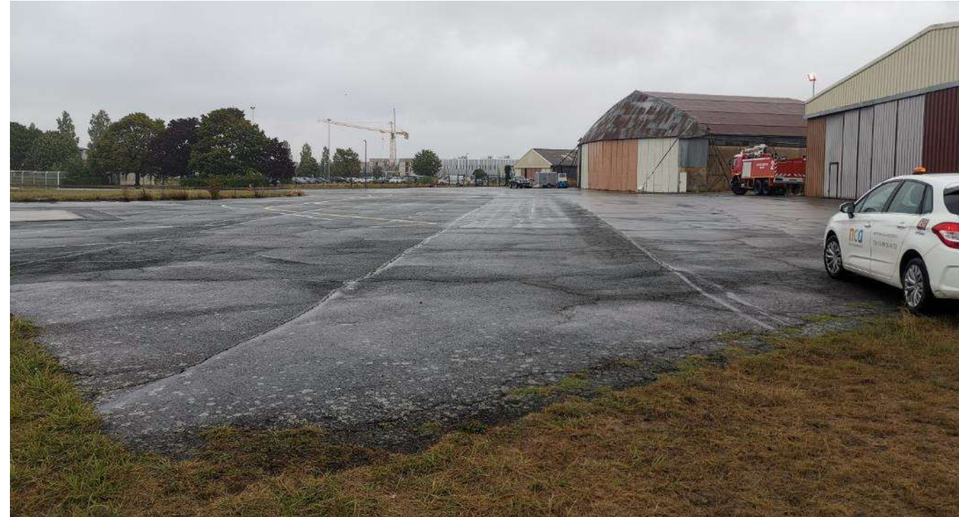
Photo 41 : Vue de la zone enrobée de circulation de l'aéroport juste au niveau de l'entrée sur site
