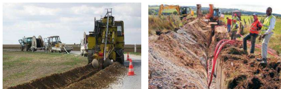
Photographie 5 : Déroulage et pose des câbles (Source : EDF Renouvelables)
